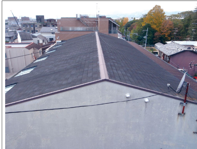
【施工前】 2013年11月 既存スレート瓦葺の状態
