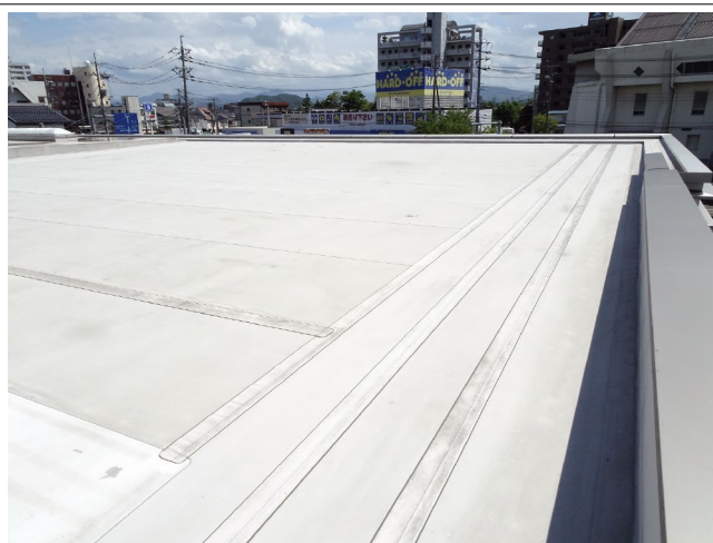
【施工前】 2018 年 2 月 既存ポリオレフィン系シート防水の状態
