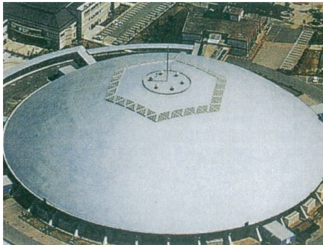
【A-2 工法 施工後】 1988 年 12 月
