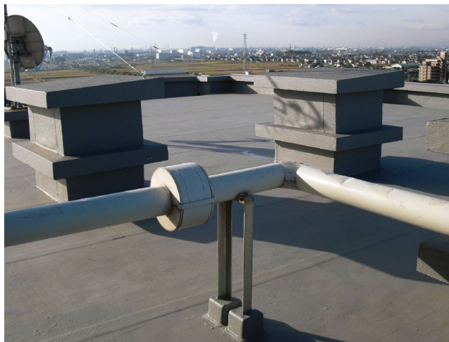
【SQ-S 工法 施工後】 2009 年 12 月
