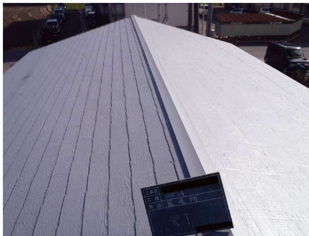
【SQ-RS 工法 施工後】 2015年2月
