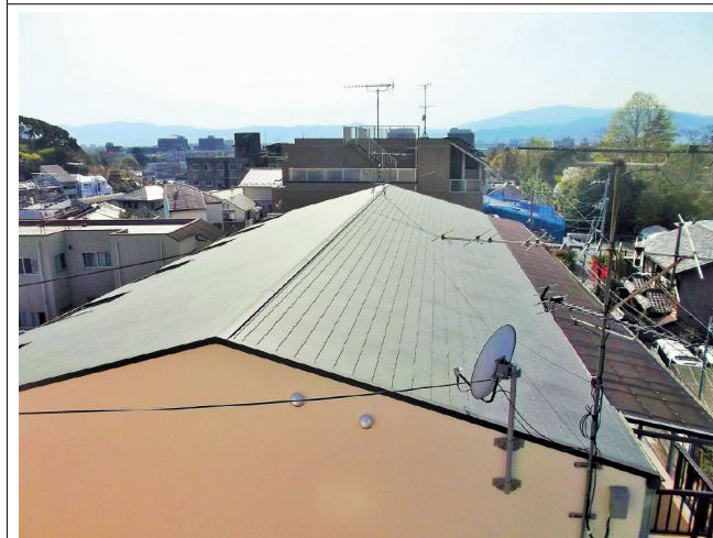
【SQ-RS 工法 施工後】 2014年4月
