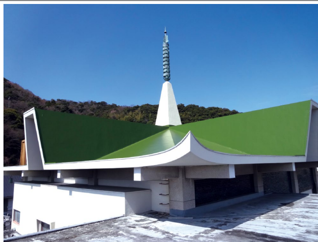
【SQ-S工法 施工後】 2015年12月
