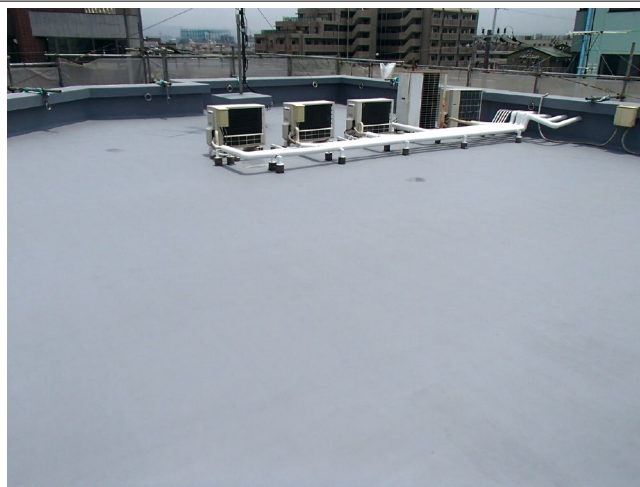
【SQ-M工法 施工後】 2015年6月
