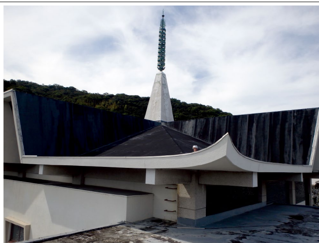
【施工前】 2015年11月 既存塩化ビニル樹脂系シート防水の状態
