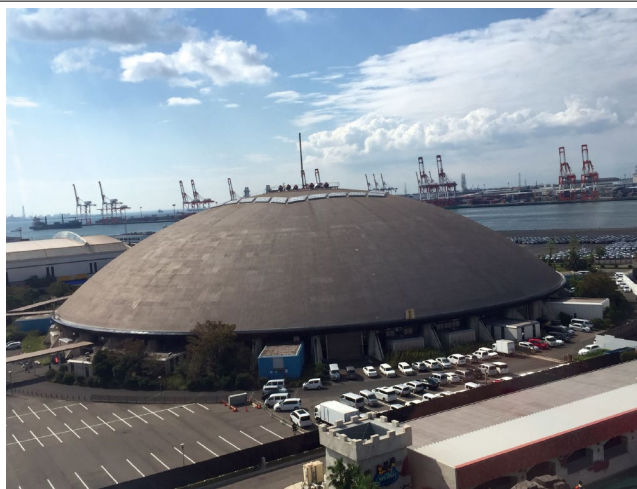
【31 年経過後】 2019 年 4 月 A-2 工法
