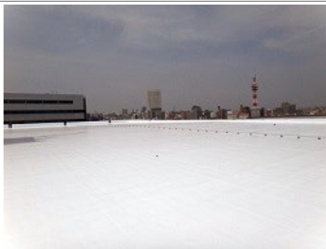
【SQ-S 工法 施工後】 2014 年 5 月
