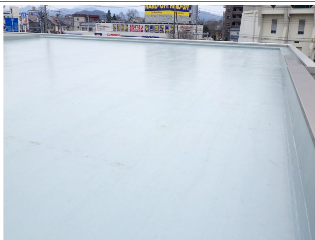
【SQ-S 工法 施工後】 2018 年 8 月
