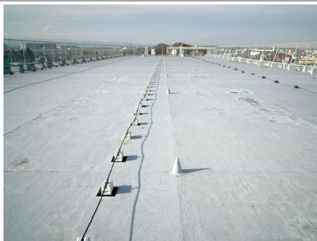
【施工前】 2014 年 5 月 既存ウレタンゴム系塗膜防水の状態
