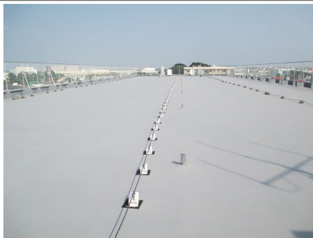
【SQ-S 工法 施工後】 2014 年 7 月
