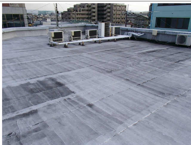
【施工前】 2015年3月 既存改質アスファルトシート防水の状態
