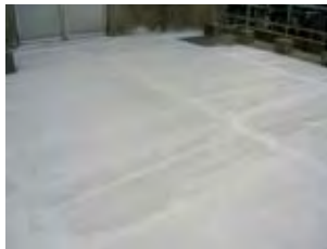
プライマー塗布
