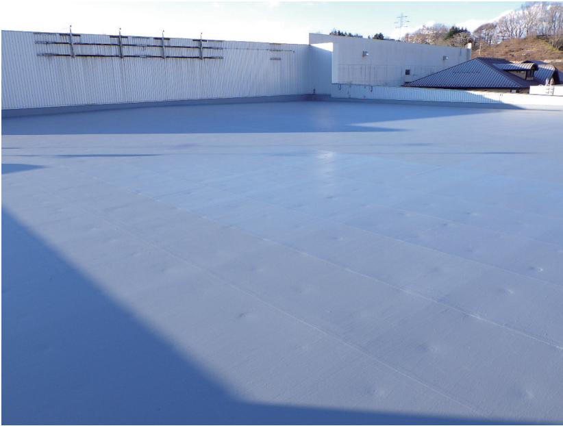
トップコート施工完了
