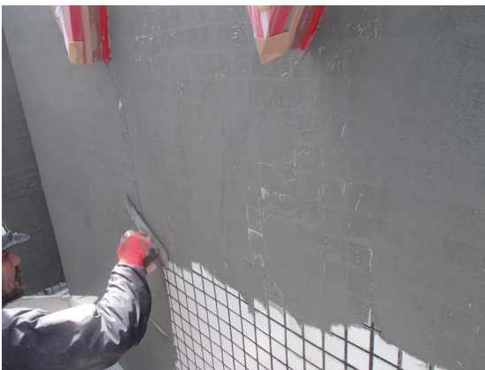
タイル面アロンカチオクリート（下塗り）
