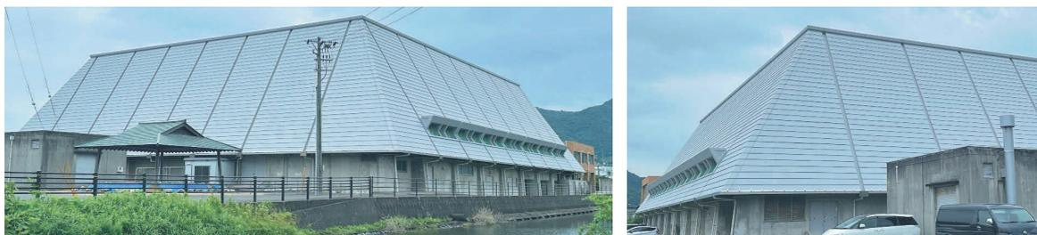
市民体育館の斜壁部分が防水処理がされていない状態だったため、アロンウオールによる防水施工を提案し、採用された。
