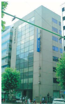
1989年に、1回目の改修工事として、タイル張り仕上面以外に、アロンウオールを施工。15年経過後の2004年に、2度目の改修工事を実施。
