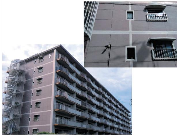
タイル面はタイルを撤去し不陸調整した後にMS工法を施工。高級感ある仕上がりとなった。
