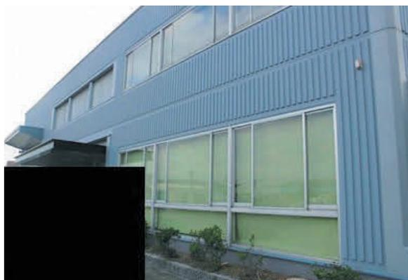
「商売をするのに漏水をしているような建物は絶対にNG」という創業者の信念から、漏水を必ず止めるためアロンウォールで施工して漏水が止まった。
