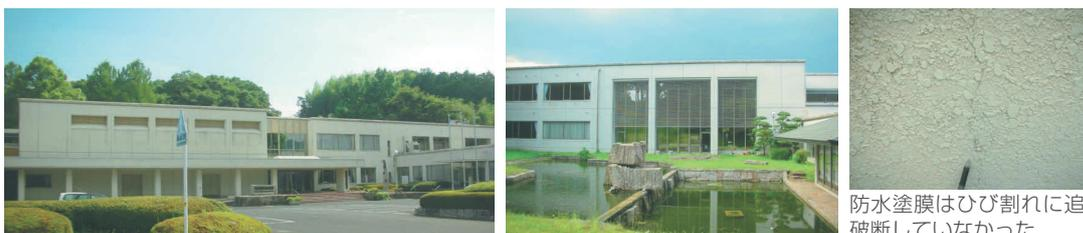
防水塗膜はひび割れに追従し、破断していなかった
