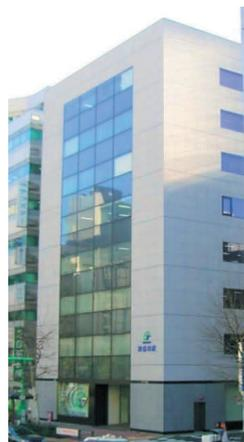
アロンウオール施工面は、アロンウオール RA-STM工法を施工。タイル張り仕上げ面は、ACCピンネット工法を施工後、MS工法を施工。
