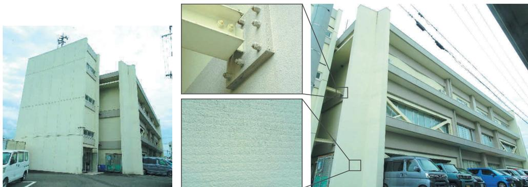
1968年竣工の建築物（築50年以上）。2013年の耐震改修時にアロンウォールで全面改修。耐震補強の鋼材との取合いはアロンウォールを被せて保護し、11年経過後も不具合なく良好な状態を保っている。
