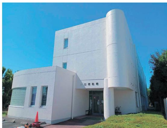
施工前に漏水が生じていたことから、防水を目的にアロンウオール STM 工法が採用された。
