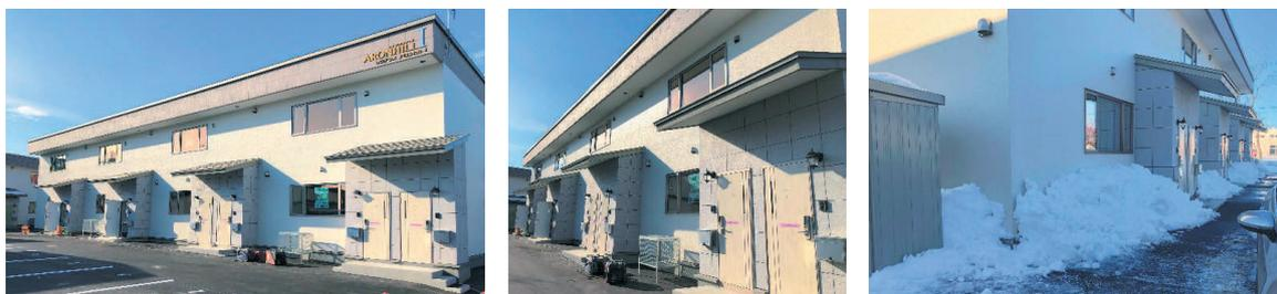
新築時に建物を長寿命化したい要望があり、外壁改修を 20 年実施しないことを目的にアロンウオール ST 工法を採用。施工後 4.1 年経過後も不具合なく綺麗な状態を維持している。
