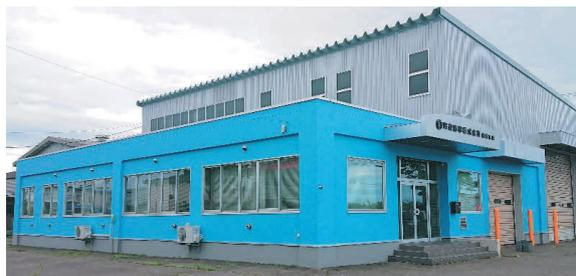
押出成形セメント板にひび割れ等の不具合が認められたため、シーリング材だけでなく、アロンウオール ST 工法により防水塗膜で一体化する提案が受入れられ、採用された。
