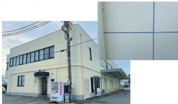
改修前の目地デザインを活かしつつ防水改修を行い、アロンコート ST を 7 回に分けて施工し、目地を色変えて塗装した。パネル外壁の意匠性を残しつつ防水改修できたことを高く評価して頂いた。
